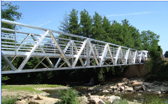
Voie verte - Passerelle 'Anciennes Gravières'
