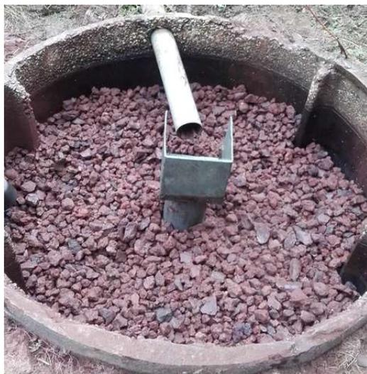
Le **préfiltre** piège les matières solides non retenues par la fosse. Il est constitué de matériaux filtrants (pouzzolane, matériaux plastique ou autres).
